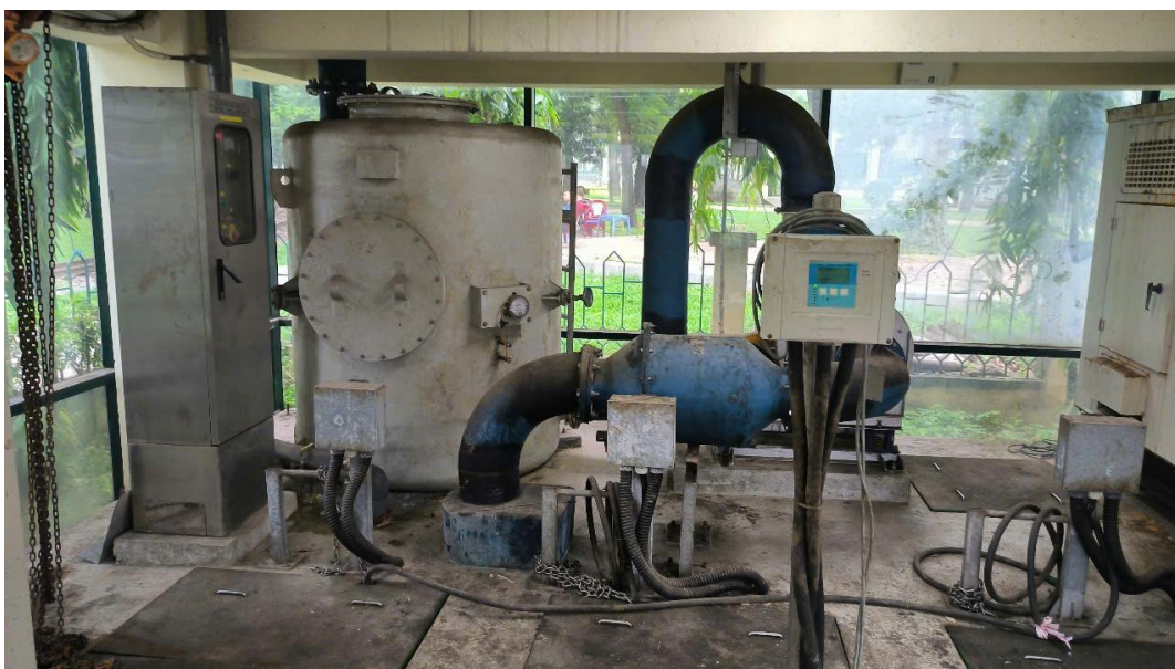
Hình 3.17: Hình ảnh hệ thống xử lý mùi tại trạm bơm nâng
